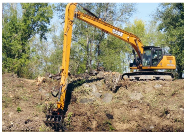
Enlèvement de la protection de berge avec pelle à bras long, 2019
