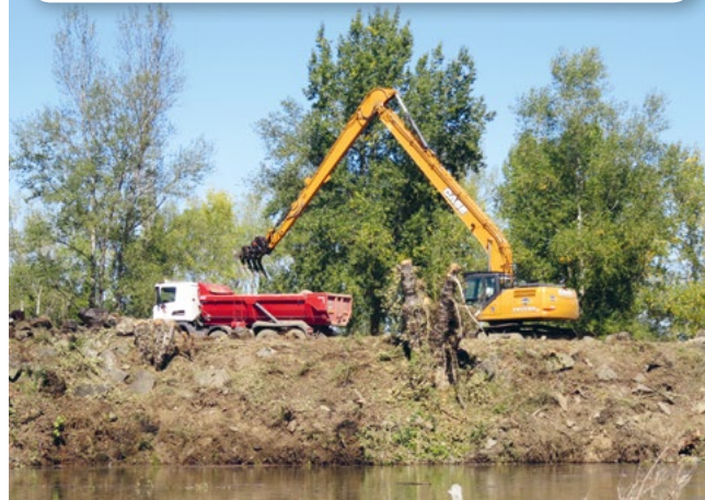
Enlèvement de la protection de berge avec pelle à bras long, 2019
