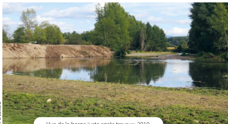
Vue de la berge juste après travaux, 2019
