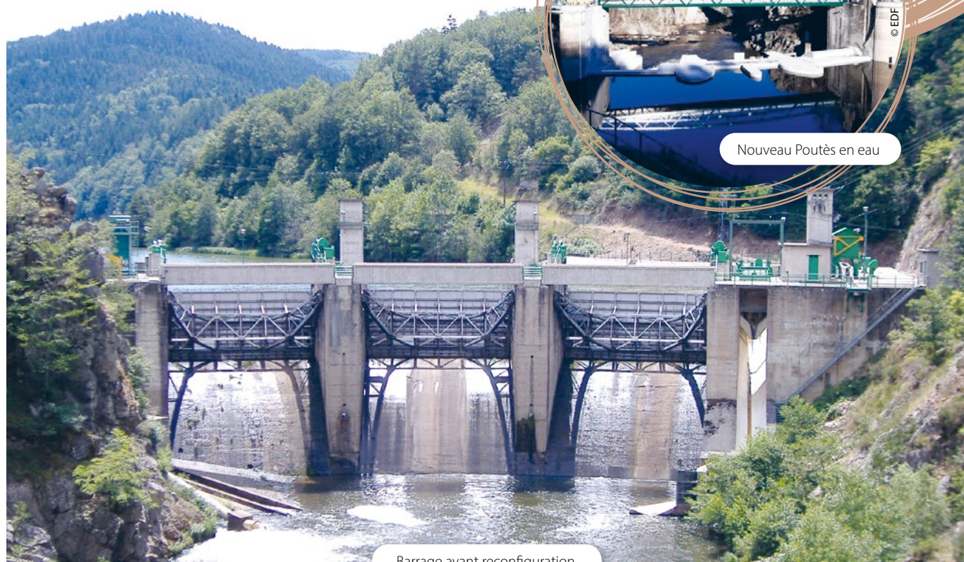
Barrage avant reconfiguration
