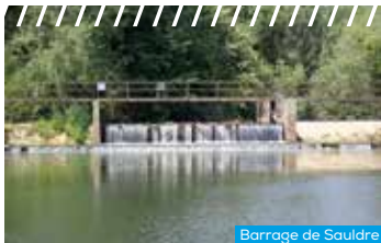
Barrage de Sauldre
